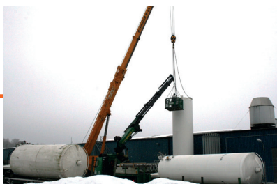
KL. 12.25 Strandmøllen sätter upp Nitrogen tank
