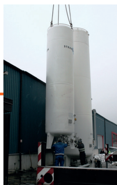
KL. 13.25 Oxygen tanken sätts på plats
